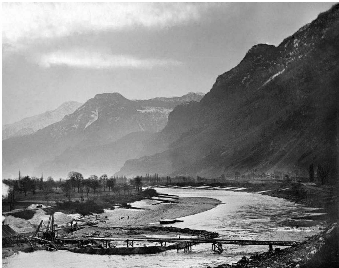
Chantier du barrage du Bois-Noir, Evionnaz, 1899-1901 © Usine de Lavey, Médiathèque Valais - Martigny
