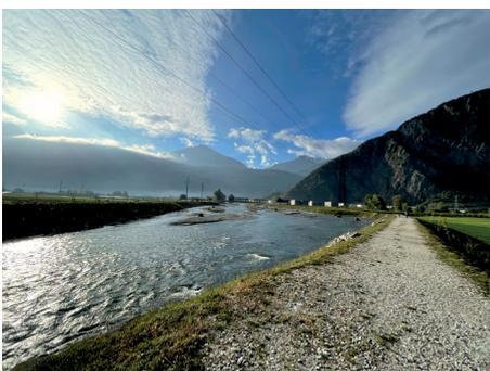
La Dranse traverse Martigny avant de se jeter dans le Rhône et draine un bassin versant de 676 km<sup>2</sup>. Lors des événements d'octobre 2000, un débit de près de 180 m<sup>3</sup>/s s'est écoulé à travers la ville, en s'approchant dangereusement du niveau supérieur des digues. Comme des crues de plus de 300 m<sup>3</sup>/s sont susceptibles de se produire dans des situations rares à extrêmes, il a été nécessaire de prévoir un aménagement global de grande importance.
