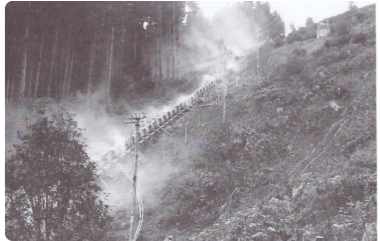
Le minerai du Mont Chemin est descendu dans des canaux en bois en 1942
